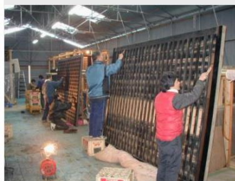
重要文化財のお寺 「部戸」(しとみど) 修復作業
